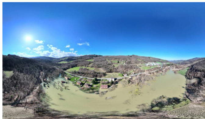
Frana che ha colpito la località di Cà di Sotto
